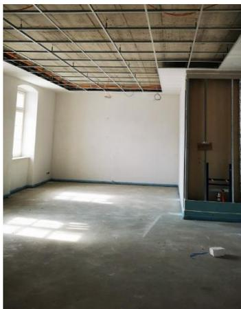
Im Inneren werden die Trockenbaudecken eingebaut, über denen die Installationen verlaufen, die Wandfriese werden angelegt. Der Neubau und die Mensa sind von außen fertig gedämmt worden, demnächst starten die Putzarbeiten außen. Kommende Woche be-
