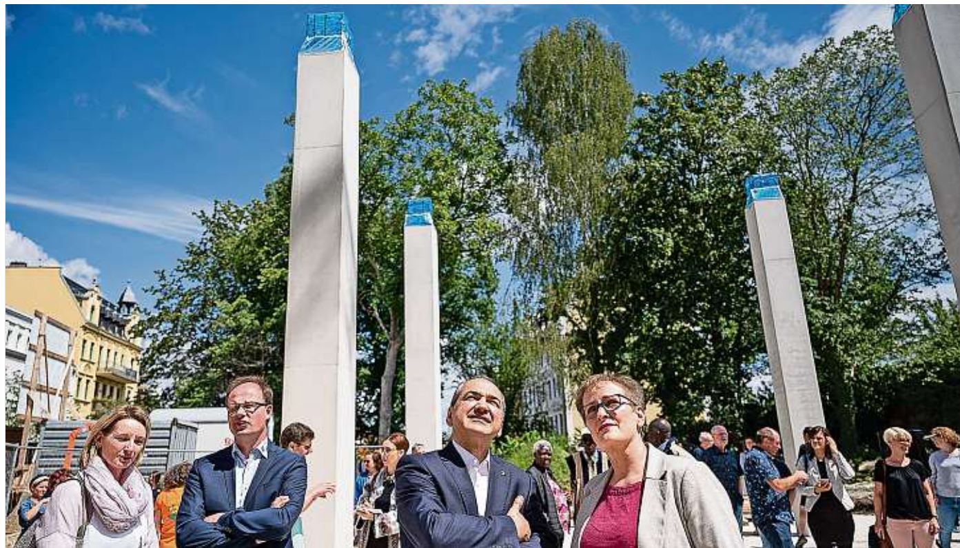
Oberbürgermeister Octavian Ursu und Cornelia Maiwald-Immer vom Evangelischen Schulverein beim Richtfest. Sie stehen zwischen den Pfeilern, auf denen der Anbau entsteht. Foto: Paul Glaser
